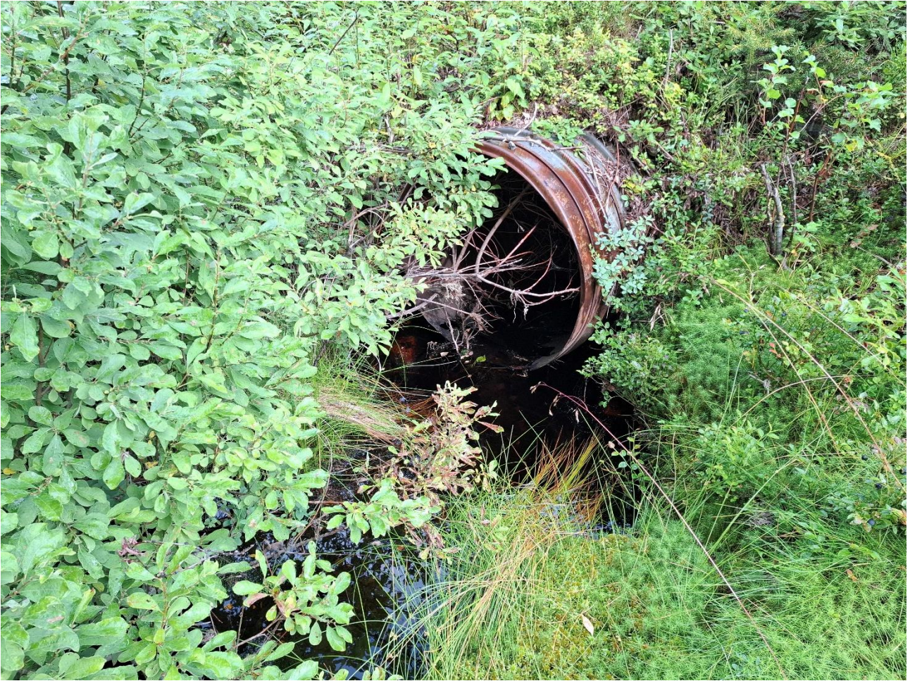
Kuva 20. Maastokäynnin aikaan Hautakyläntieltä etelään kaartuvan metsäautotien alla oleva rumpu oli vaellusesteinen.
