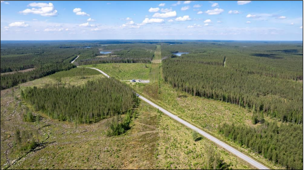
Kuva 5. AKDG7431:38. Uusi voimajohto liitetään nykyiseen voimajohtoon nykyiselle voimajohtoreitille rakennettavalla sähköasemalla. Kuva olemassa olevasta voimajohdosta etelästä pohjoiseen kuvattuna. Kuvassa sähköasema Itämaellä ja nykyinen voimajohto. Kuvauskopterin kuva kaakosta.
