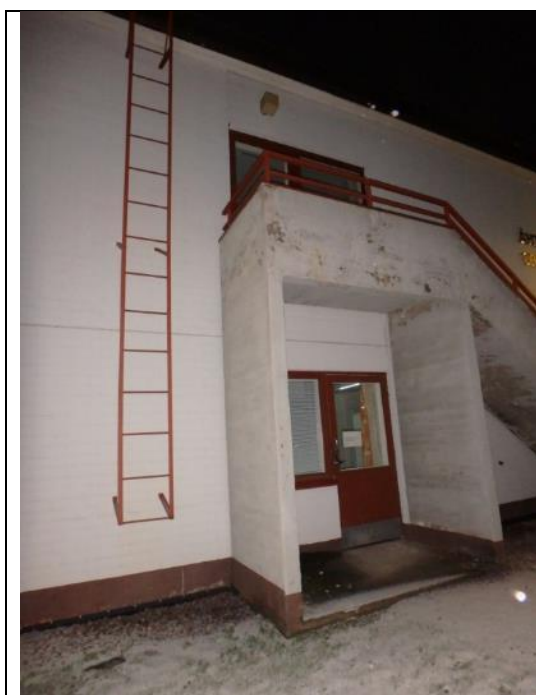
Säärasitetut maalatut betoniosat ovat menettäneet maalipinnoitettaan.
