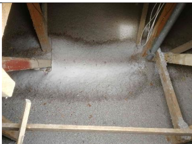
Tuiskunutta lunta pääsee harjapelin alta yläpohjaan.
