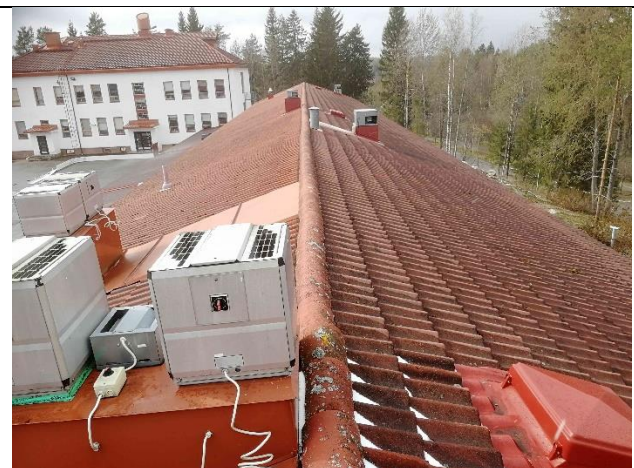
Yleiskuva vesikatteesta. Kulkusiltojen puuttuminen vaikeuttaa huoltoa.
