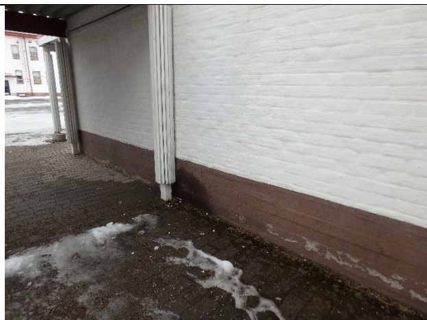
Sokkeliin kohdistuu kosteusrasitusta. Salaojitus loppuu kuvan oikeaan reunaan.
