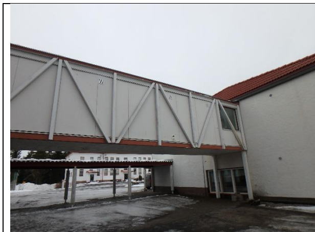
Rakennuksen yhdistää yläasteeseen katos sekä kulku-putki.
