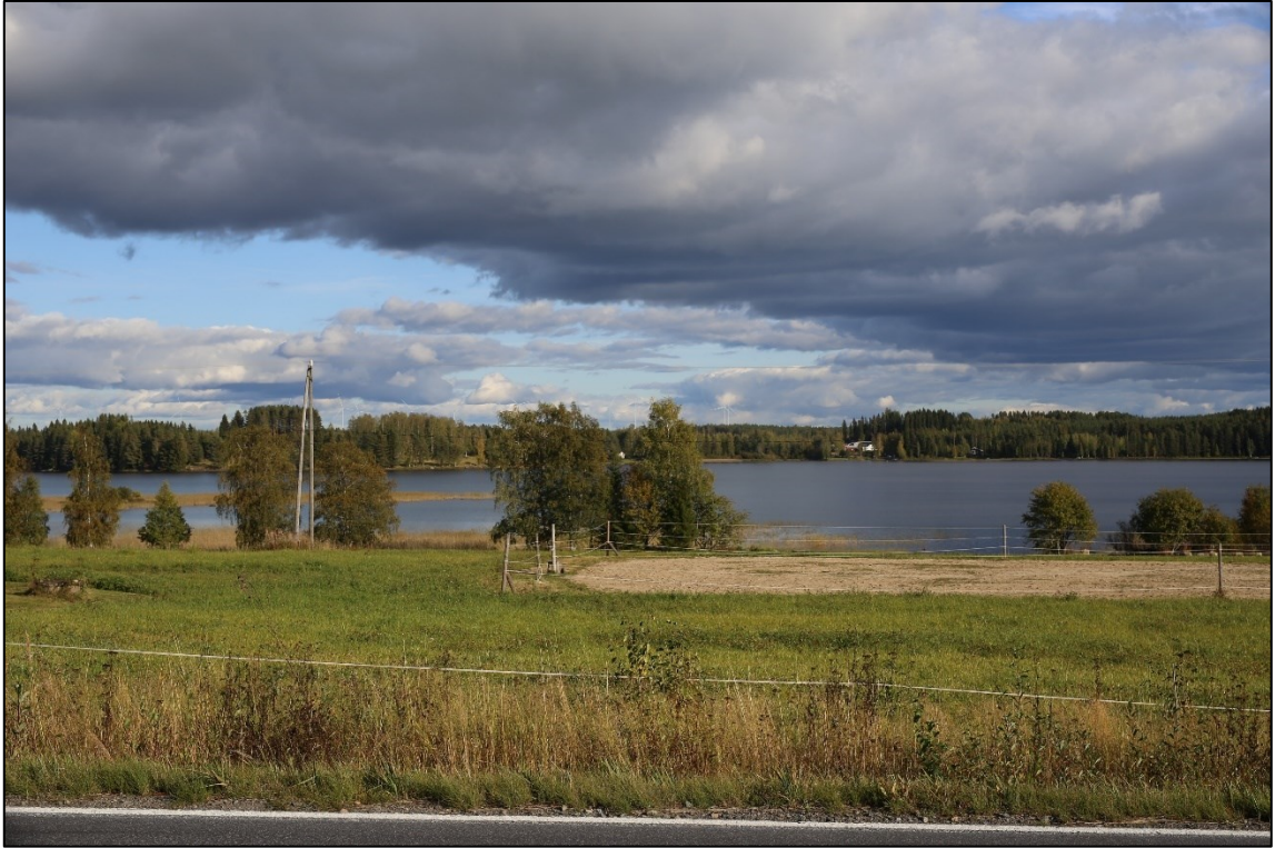
Kuva 10.10. Kuvasovite kaava-alueen länsipuolelta Ähtärinjärven länsirannalta. Etäisyys lähimpiin voimaloihin noin 10,0 km. Voimaloiden lavankärjet ovat paikoin näkyvissä puuston latvuston yläpuolella. Voimalat jäävät taustamaisemaan ja erottuvat yhtenäisenä ryhmän suhteellisen kapeassa sektorissa. Maiseman muutos on vähäinen.
